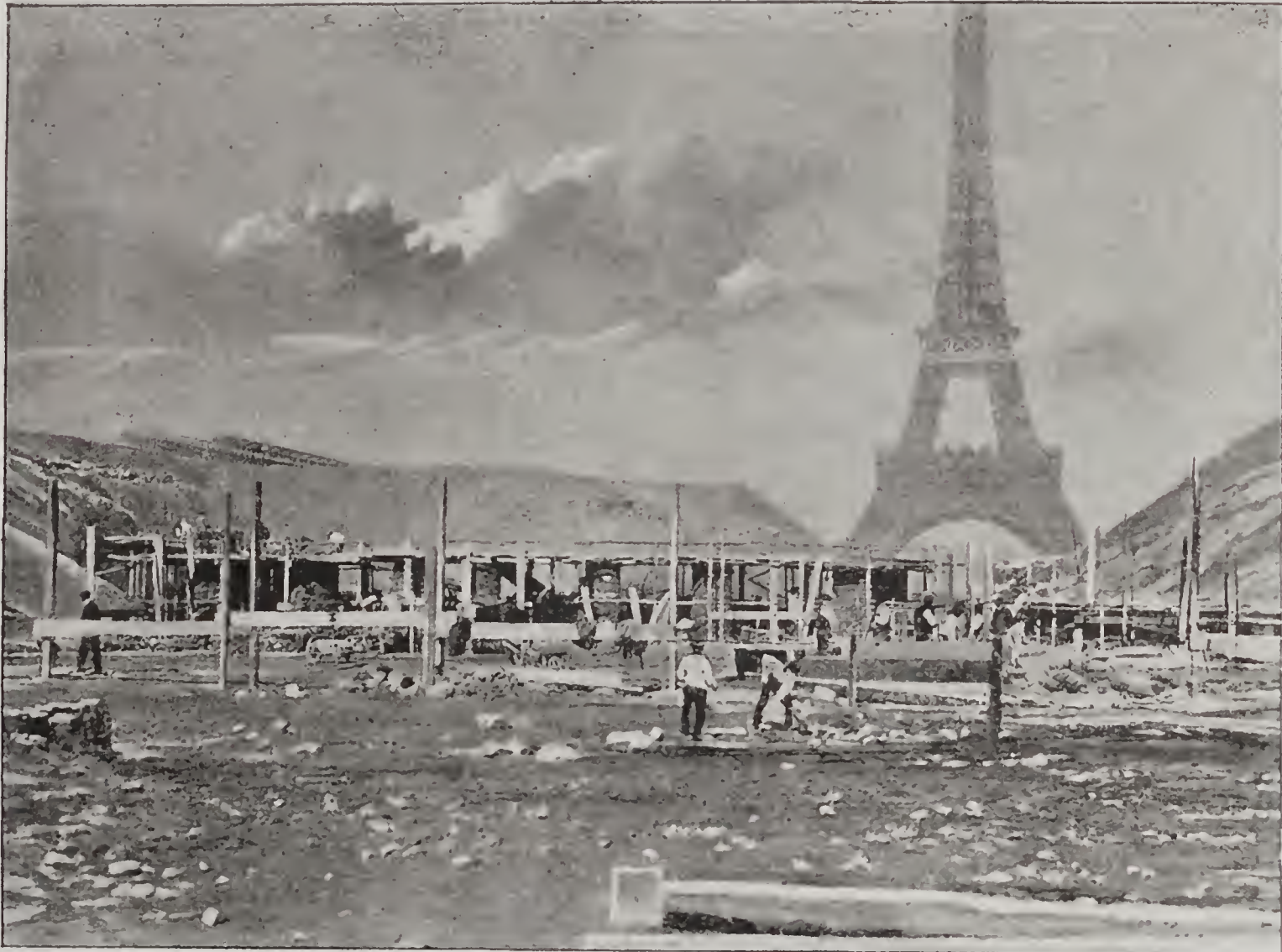
LE CHATEAU D'EAU MONUMENTAL. — Commencement des travaux de maçonnerie.
